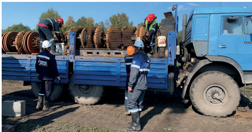
На газопровод-отводе от ГРС-1 до ГРС-2 г. Новокузнецка впервые за 45 лет работы проведена внутритрубная диагностика
