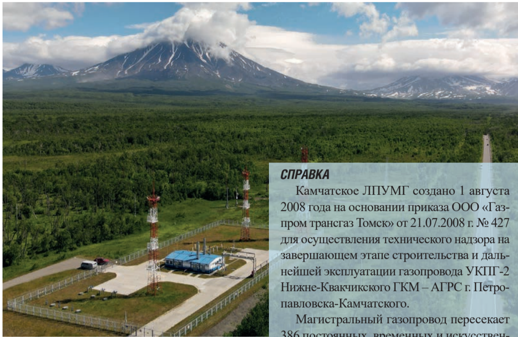
Вид на ГРС г. Елизово
