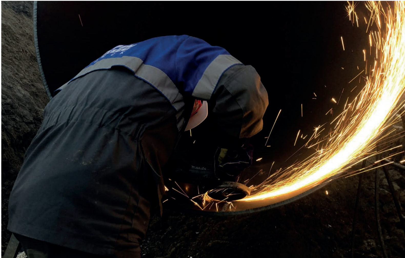
Ремонтные работы часто проходят в круглосуточном режиме
