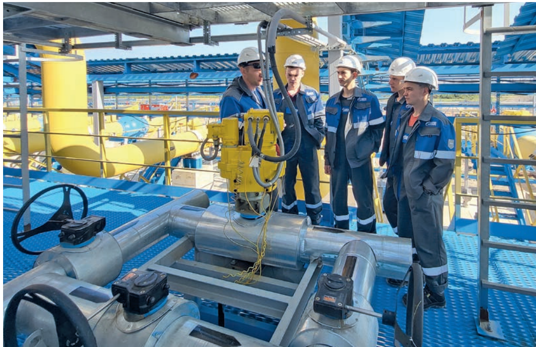
Знакомство с оборудованием компрессорной станции в Нерюнгринском ЛПУМГ
