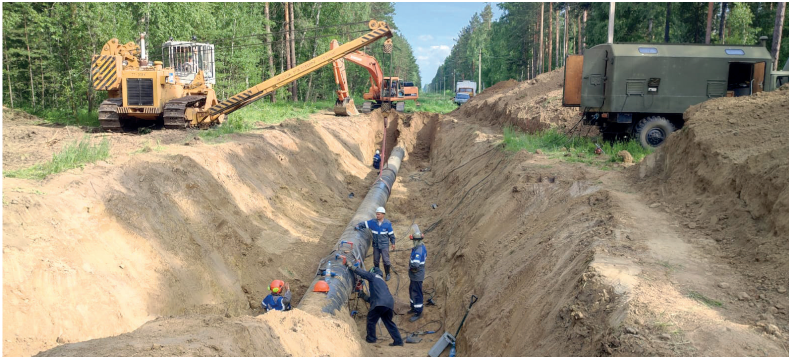
Устранение дефектов на МГ Новосибирск – Барнаул
