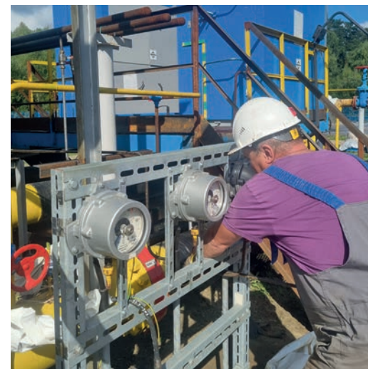
Специалисты УАВР проводят капитальный ремонт ГРС «ТЭЦ СХК»
