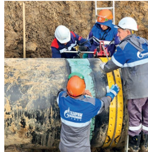
Вырезка дефектного участка газорезательной машиной «Орбита»
