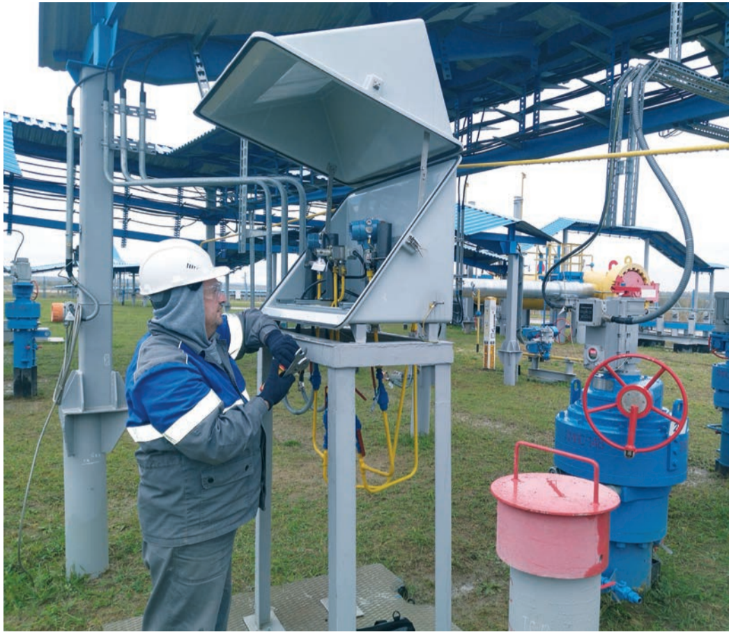
Обслуживание датчика давления на узле подключения КС «Атаманская»
