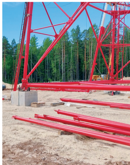
Строительство участка «Ковыкта – Чаянда»
