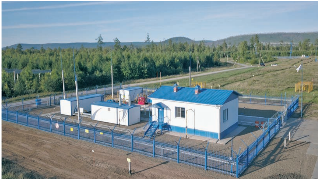
Газораспределительная станция в Братске
