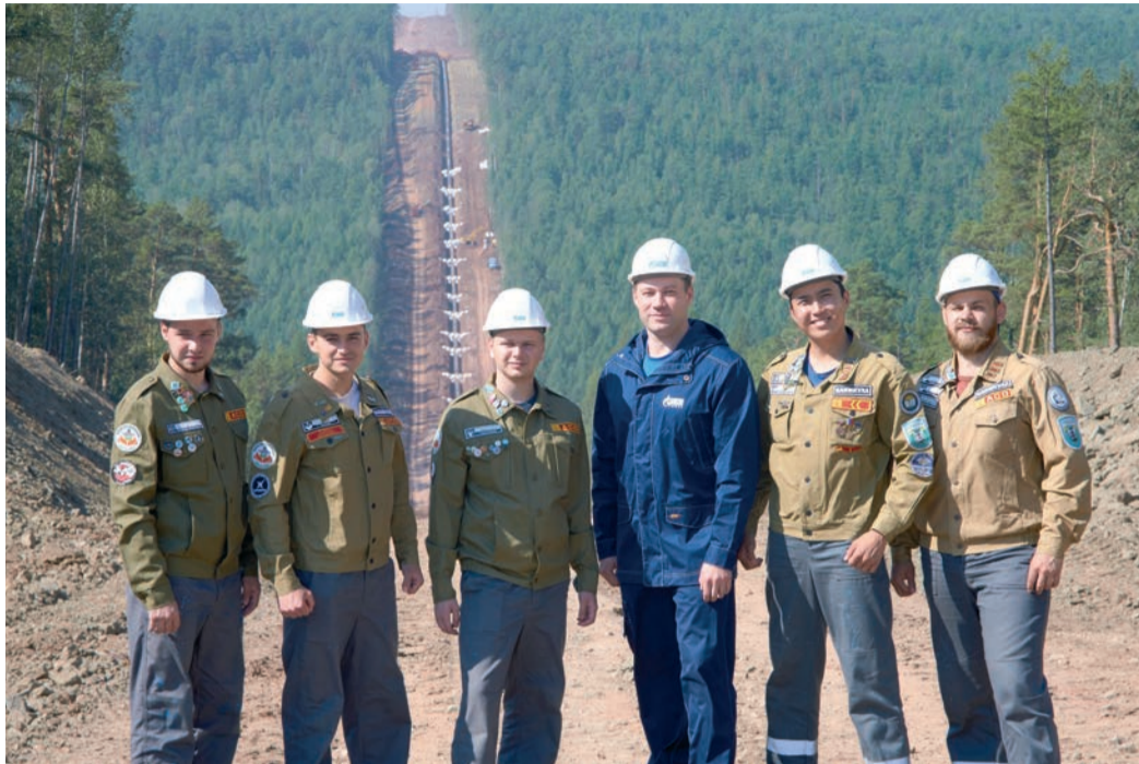
Директор Иркутского ЛПУМГ Александр Пыкин и студенты строительного отряда «Каникула» на строительстве участка Ковыкта – Чаянда, 2021 год
