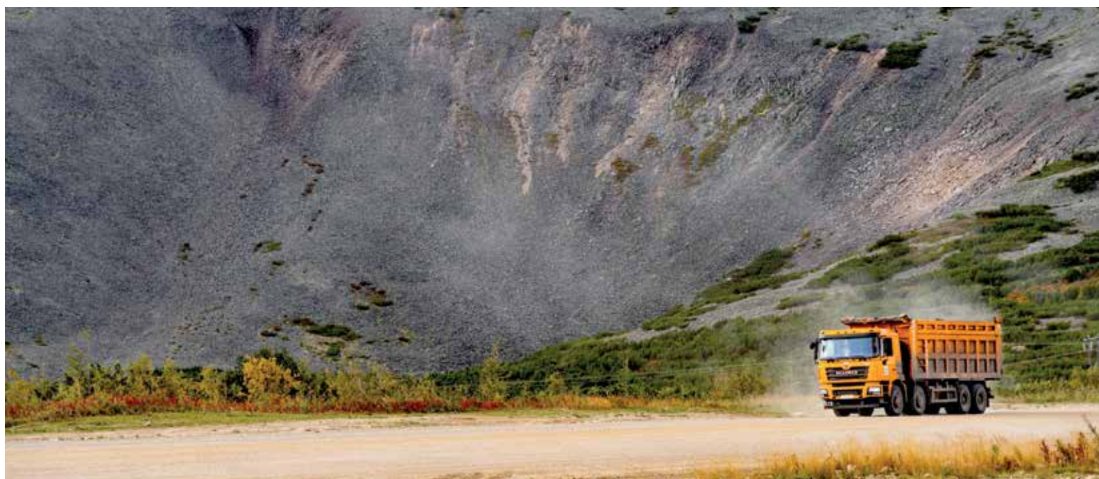
Скалистые грунты осложняют работу строителей
