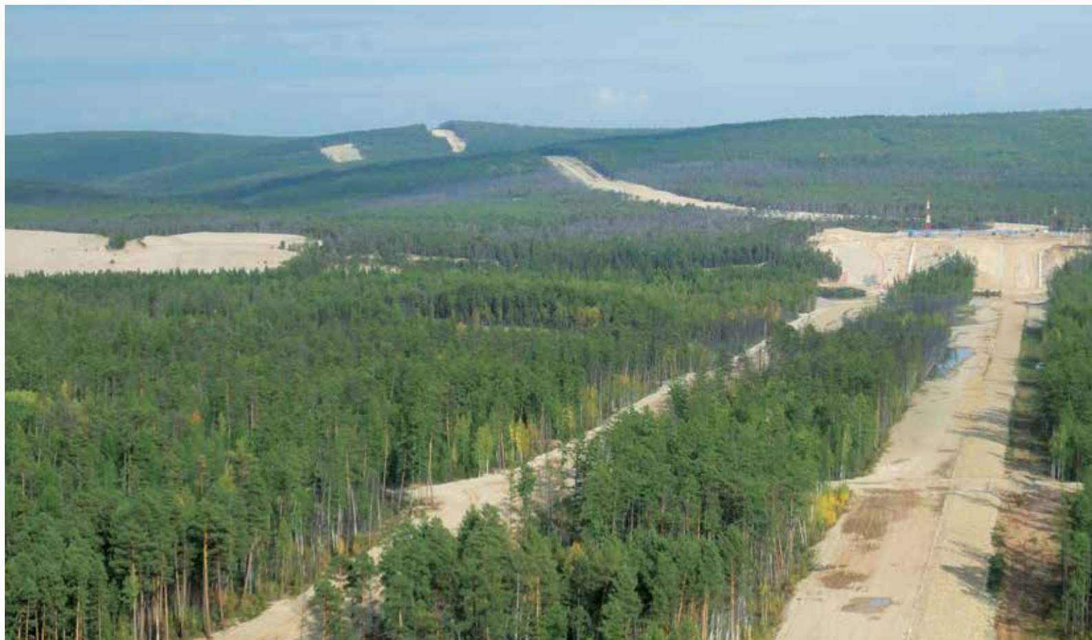
Газопровод часто проходит по участкам со сложным рельефом местности
