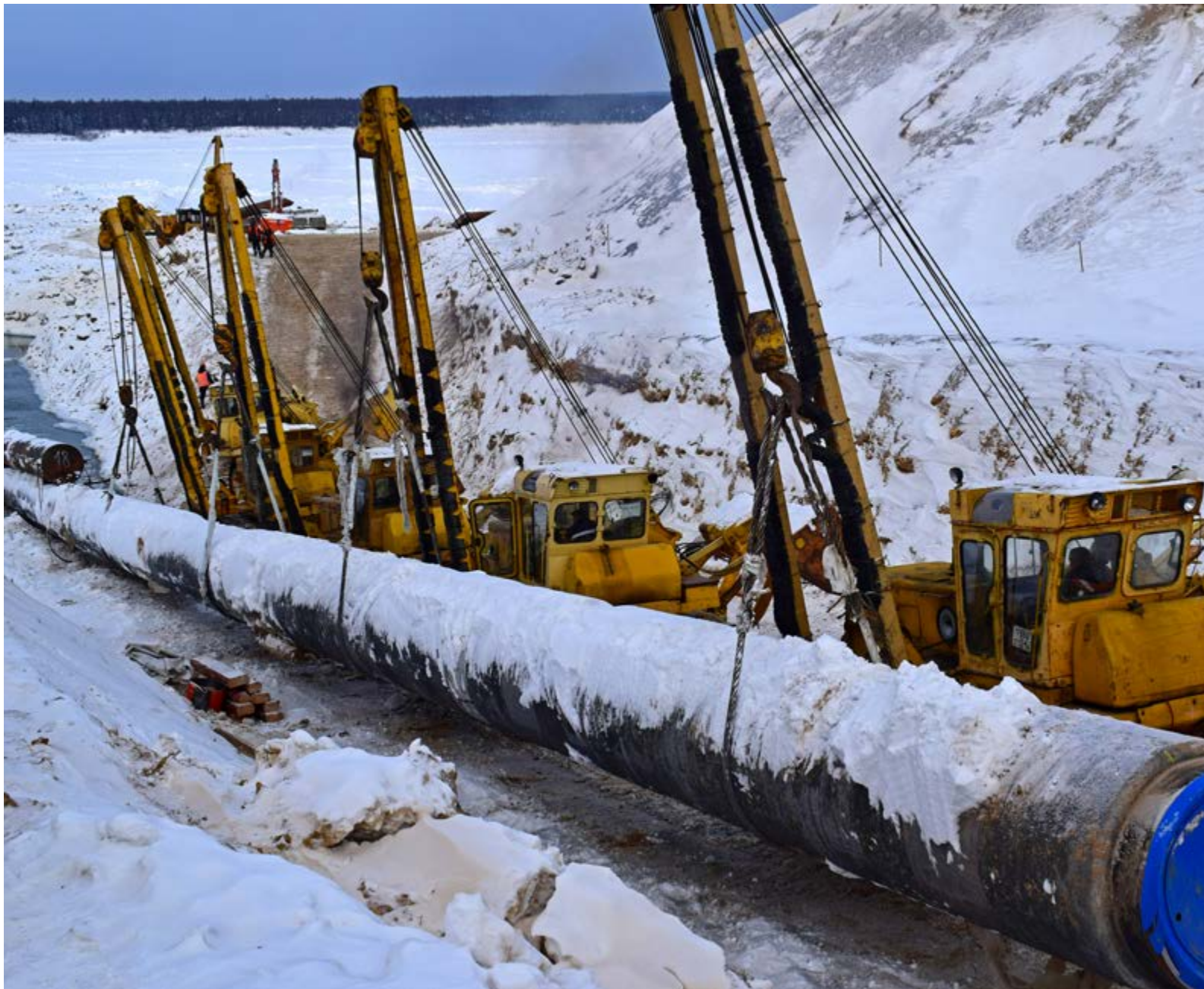
Переход через реку Лену – самый протяженный на пути от Чаяндинского месторождения к Китаю
