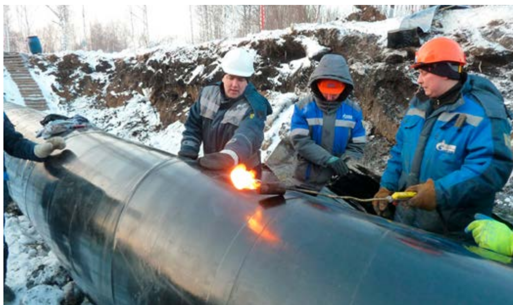
На некоторых участках замена трубы не требуется, но обновление изоляционного покрытия даст большой эффект
