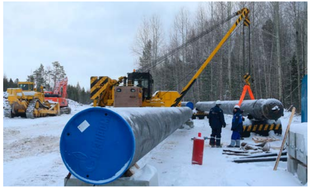
Эта труба будет проложена под автодорогой Парабель – Прокоп
