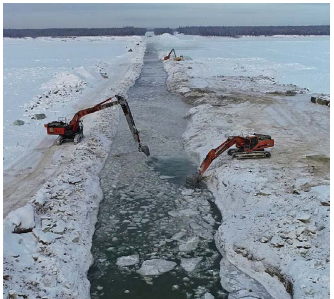
Во время рытья траншеи подводного перехода экскаваторы работают без остановок
