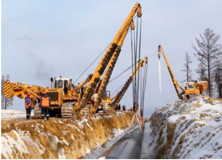
Подготовка к испытаниям магистрального трубопровода на крановом узле 523
