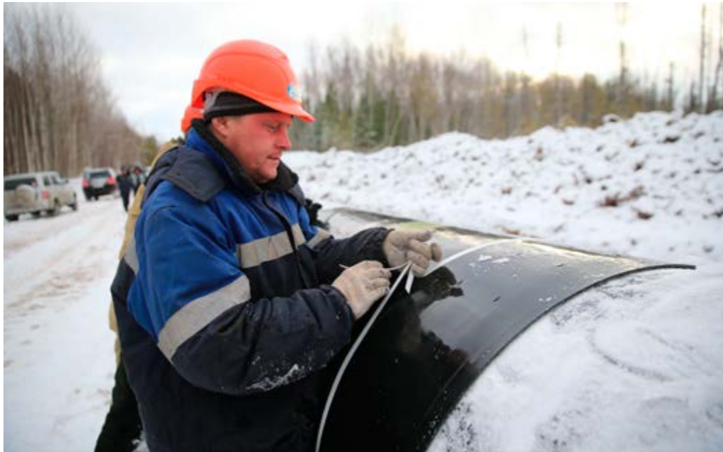
Скальный лист защищает изоляционное покрытие от повреждений при использовании утяжелителей
