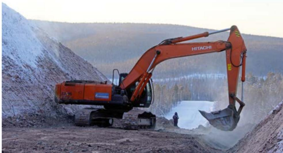
Косогоры в Якутии настолько круты, что приходится срезать грунт для устройства технологического проезда
