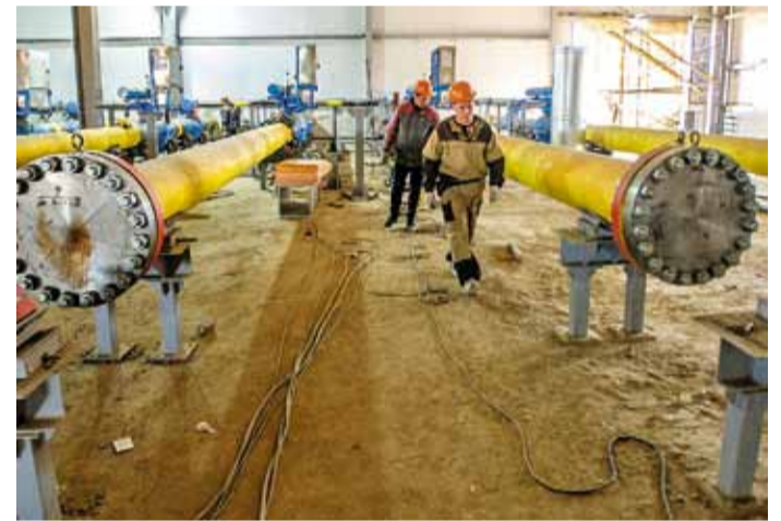
ГИС рассчитана на восемь измерительных линий
