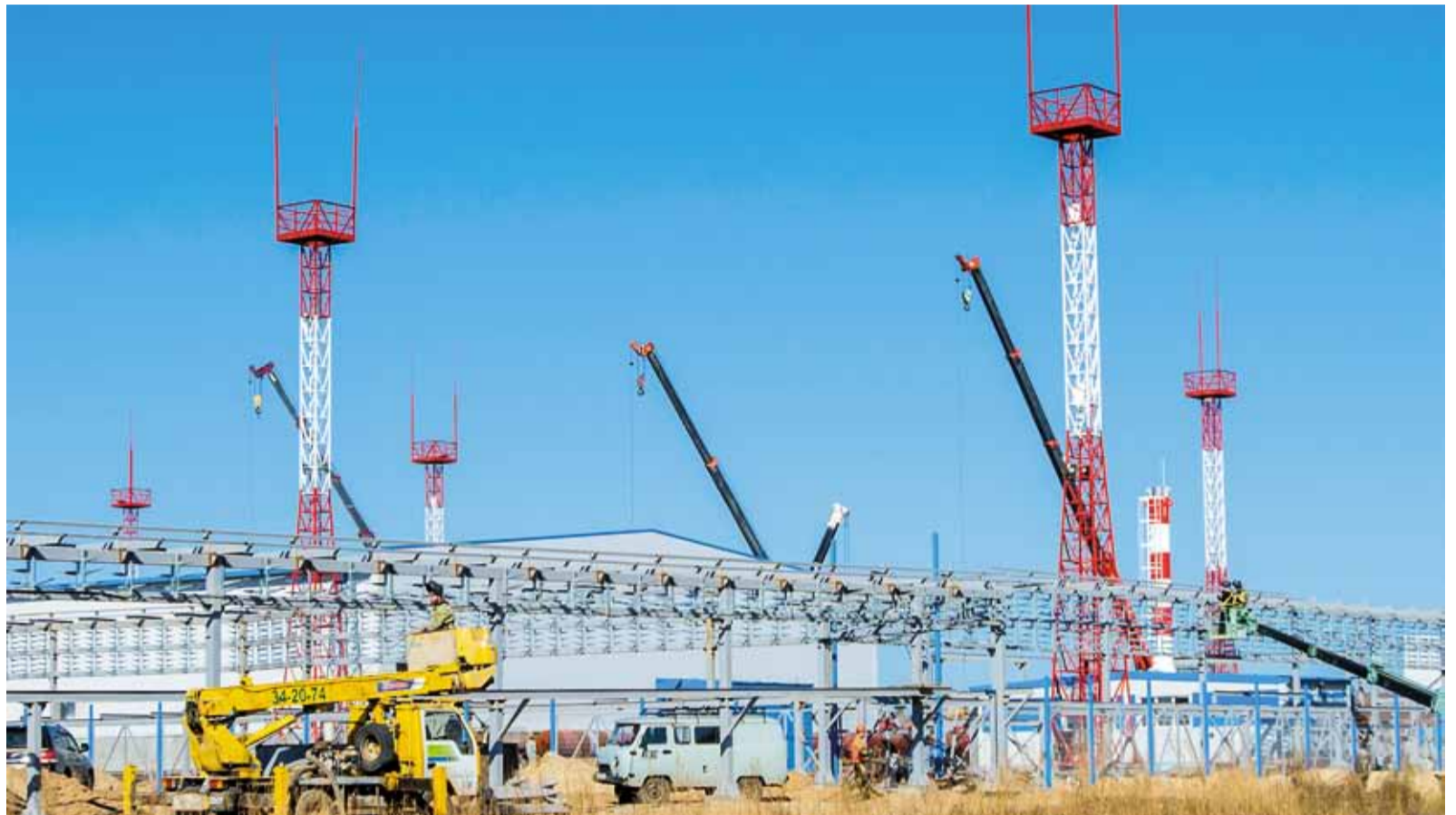
Основные строительные работы на газоизмерительной станции близки к завершению
