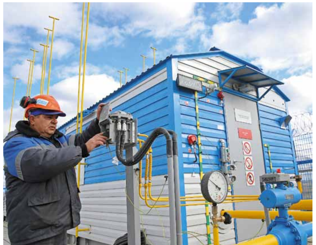
С завершением ремонта газораспределительная станция «Медведское» (Новосибирская область) стала современной, компактной и полностью автоматизированной
