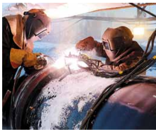
Полуавтоматическая сварка на трубосварочной базе
