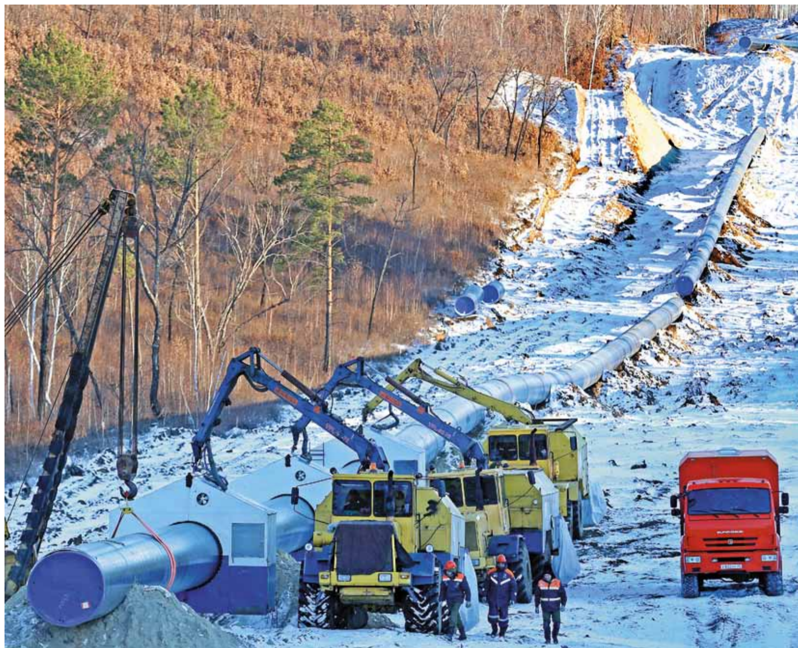
Активно развернулось строительство магистрального газопровода «Сила Сибири» на участке РУСО в городе Свободном
