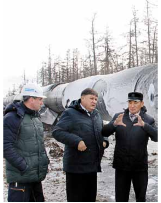
Петр Лавров ознакомил главу Олекминского района Виктора Васильева с ходом строительства
