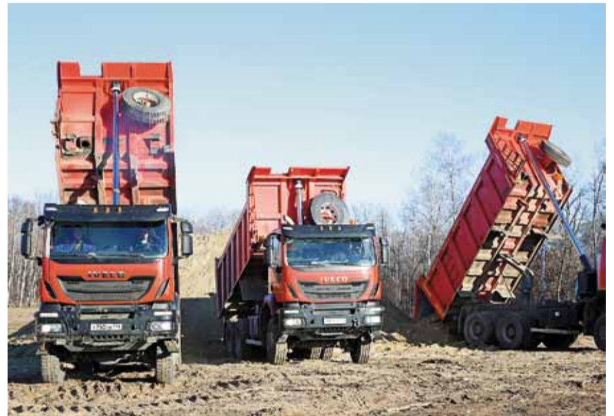
Ведутся работы по обустройству площадки «закрытой зоны»
