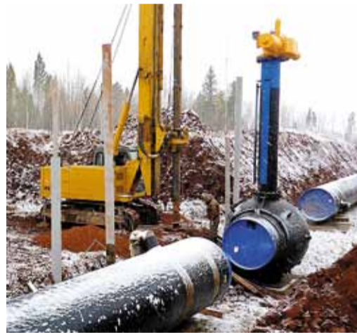
Первый крановый узел на трассе Ленского ЛПУМГ
