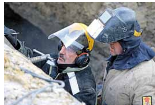
Подготовка к сварке
