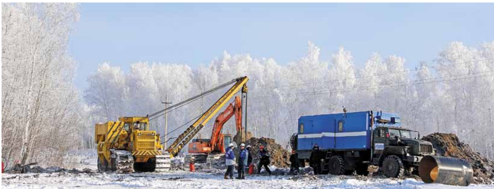
Работы шли одновременно в двадцати местах газопровода Омск – Новосибирск
