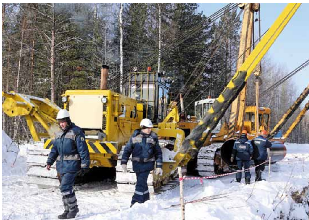
Все запланированные ремонтные работы завершены в срок
