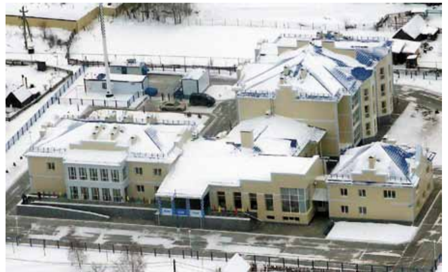
Здание стоит в самом центре старинного сибирского села
