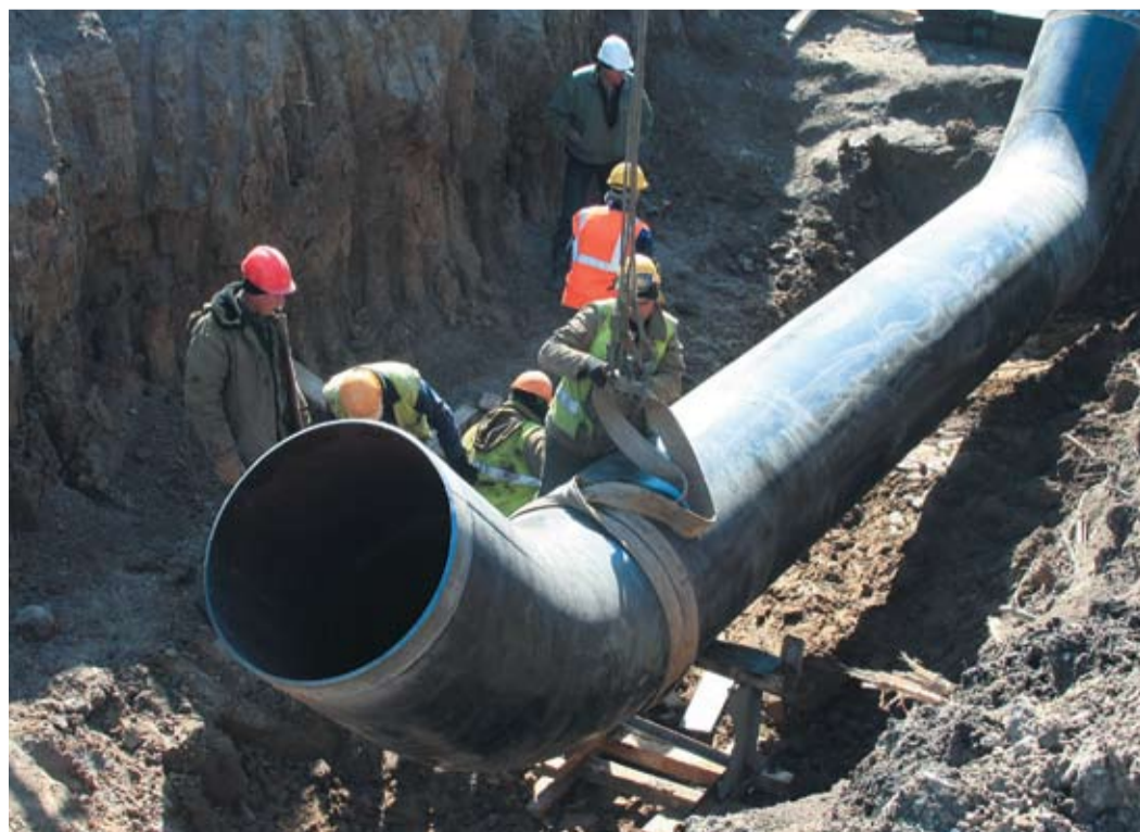
Укладка подводящего газопровода
