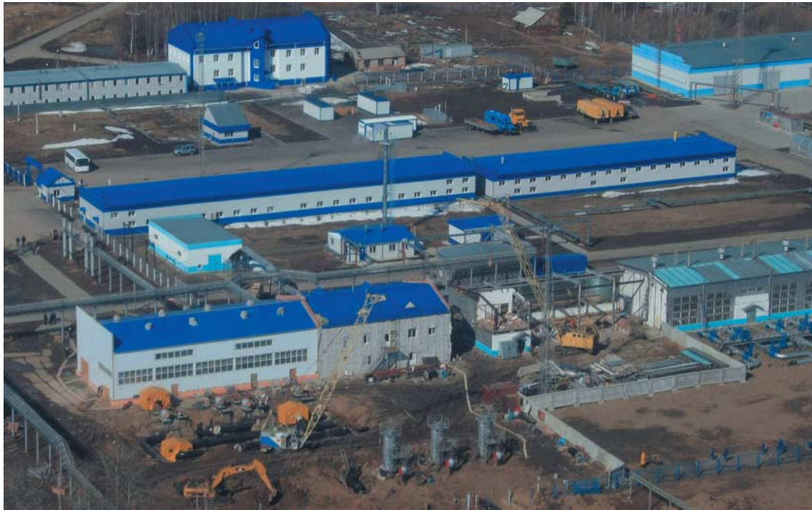
Работы на КС «Володино». Внешне станция уже соответствует фирменному стилю компании
