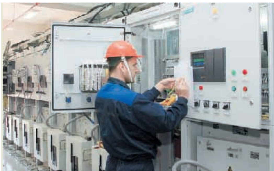
Настройка электрооборудования на компрессорной станции «Володино»
