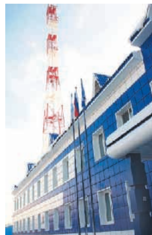
Бийская промплощадка – новый производственный объект компании «Газпром трансгаз Томск»
