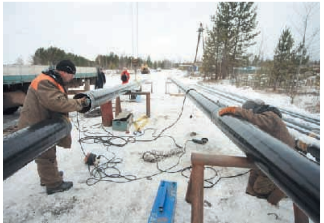
Строительство газопровода – отвода в городе Братске. Работы планируется закончить в декабре
