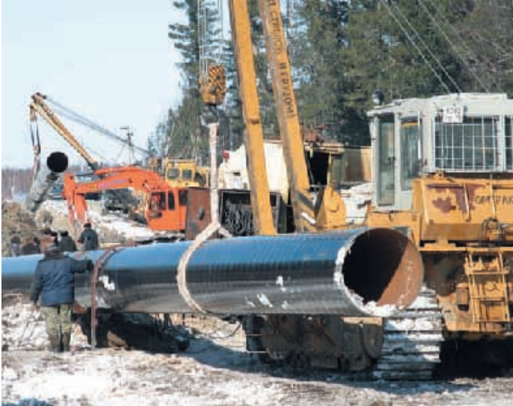
Подготовка к зиме включает в себя несколько больших комплексов работ по ремонту линейной части магистрального газопровода
