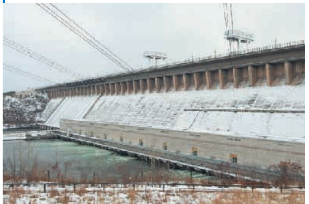
Братская гидроэлектростанция считается одной из самых мощных в России
