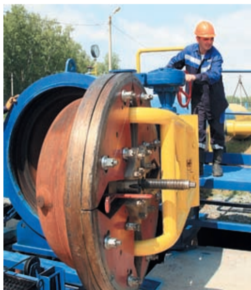
По программе текущего ремонта на УП КС «Тюкалинская» и УП КС «Ивановская» хомутовые камеры запуска будут заменены на концевые секторного типа
