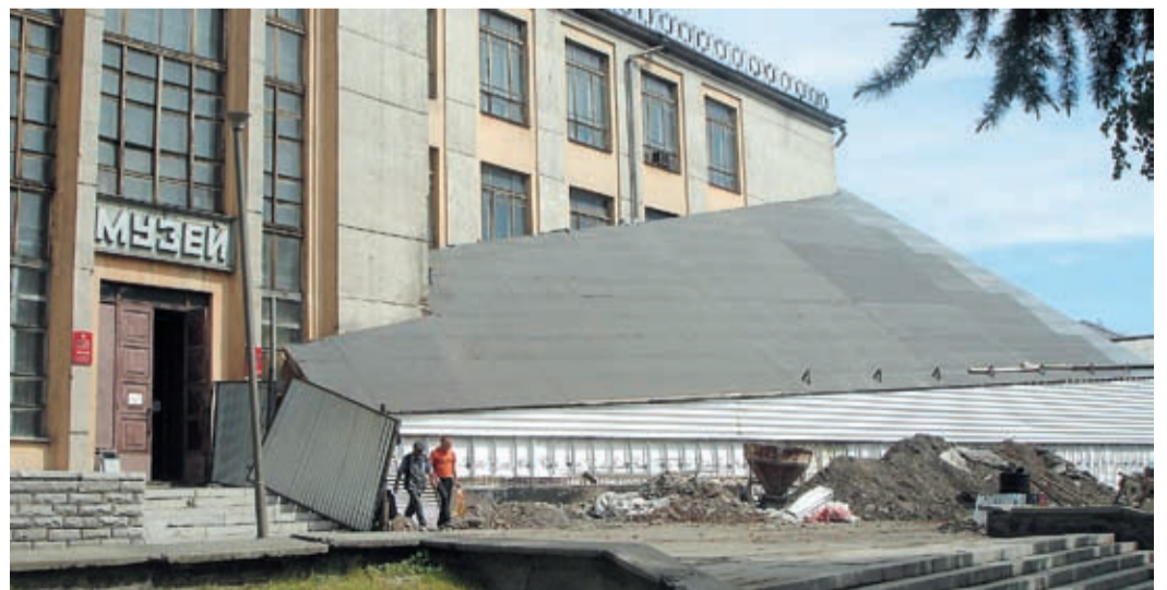
Работы по реконструкции объекта ведутся согласно графику
