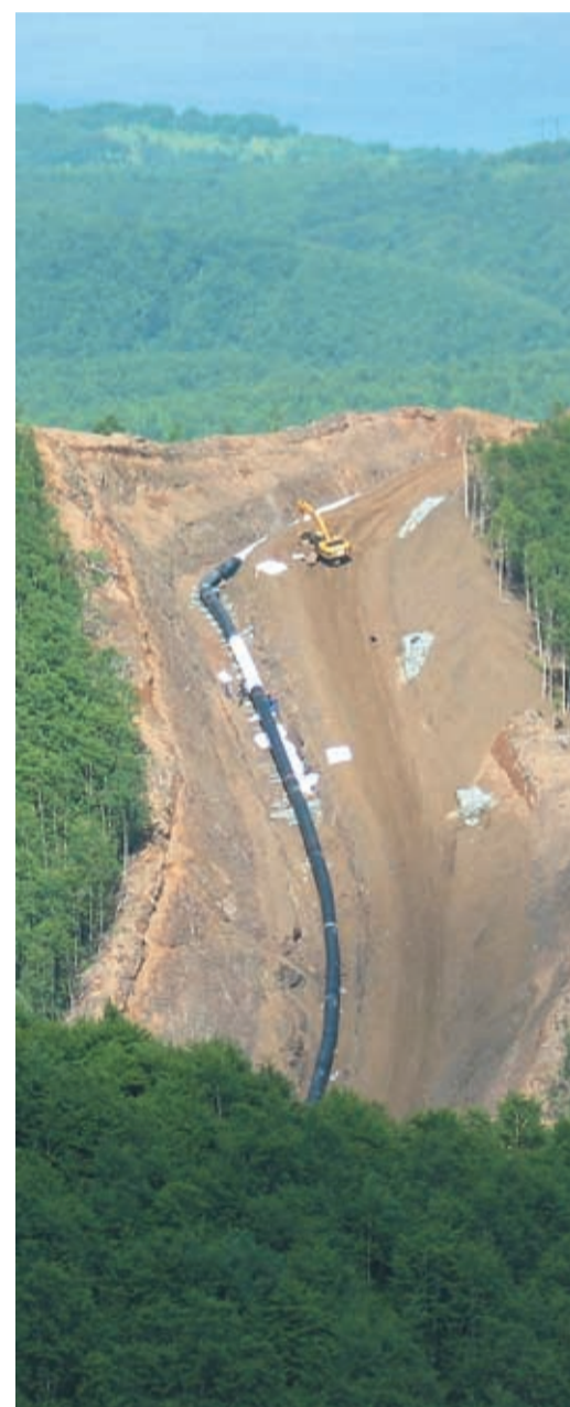
Транссахалинская трубопроводная система – одна из самых сложных в мире. Укладка трубы, 2008 год
