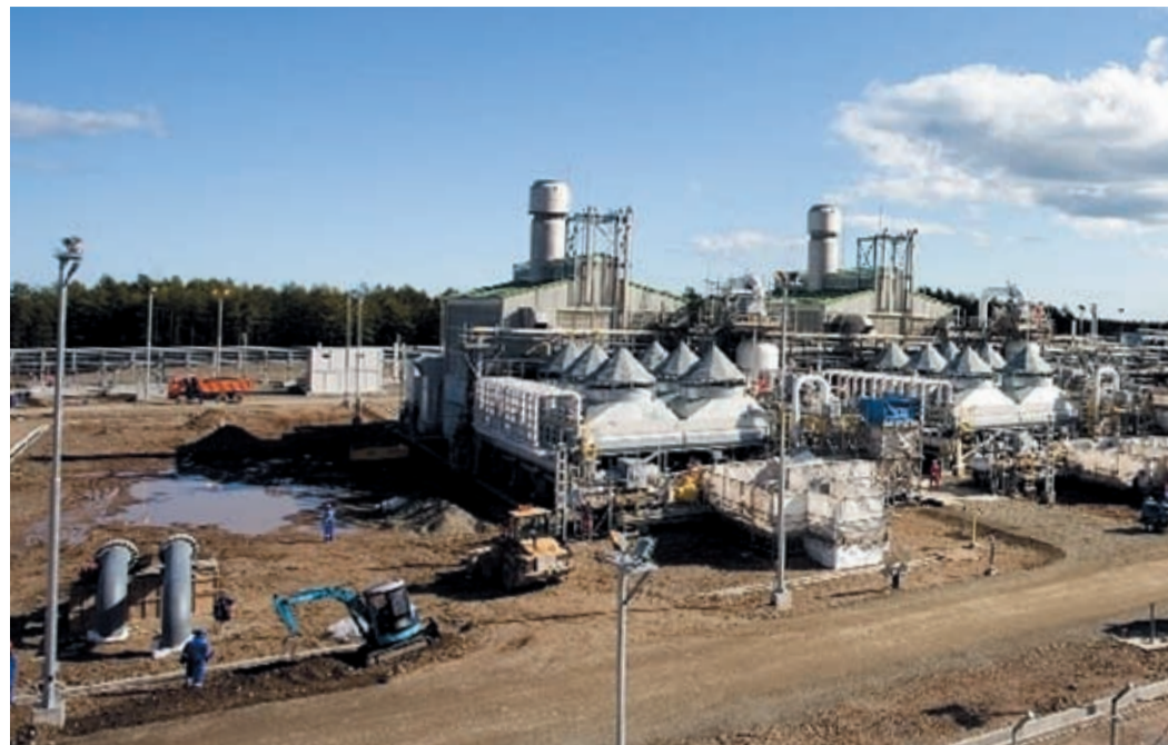
«Насосно-компрессорная станция-2» в посёлке Гастелло (период окончания строительно-монтажных работ)
