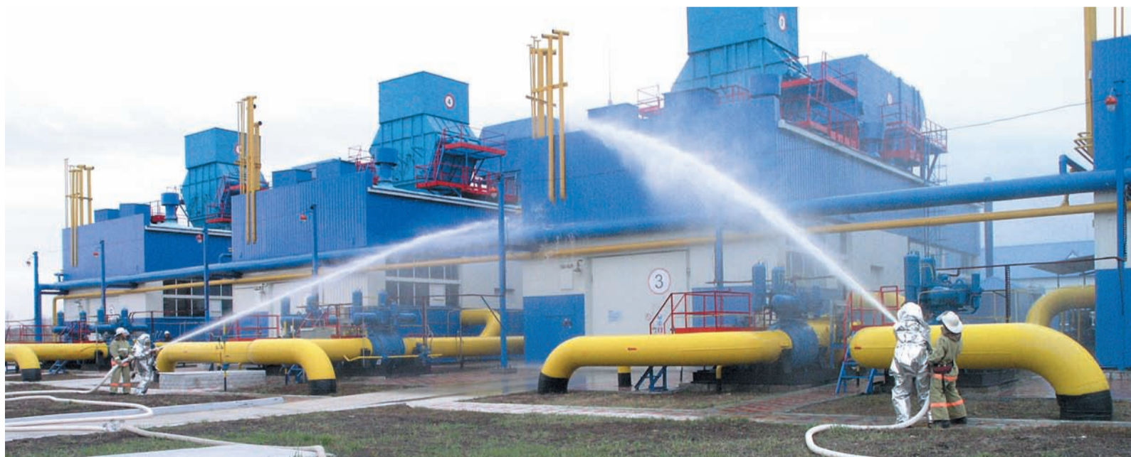
Ликвидация условного пожара на КС «Кожурла» прошла успешно
