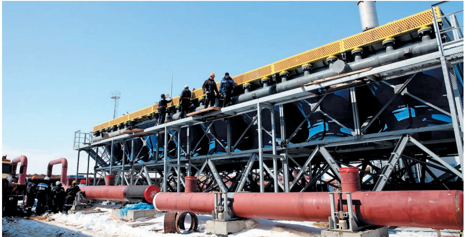
На площадке строительства головной компрессорной станции «Сахалин»
