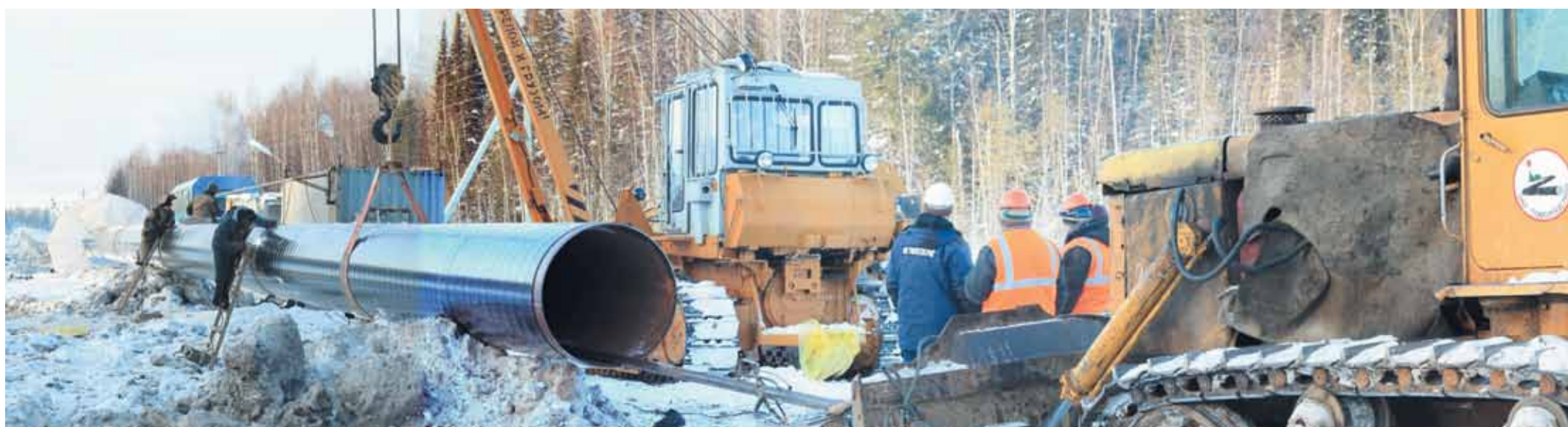
Ремонт линейной части газопровода – важная часть программы подготовки к зиме
