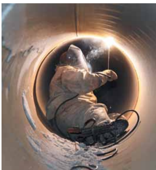
Качественная работа сварщика – залог надёжности газопровода
