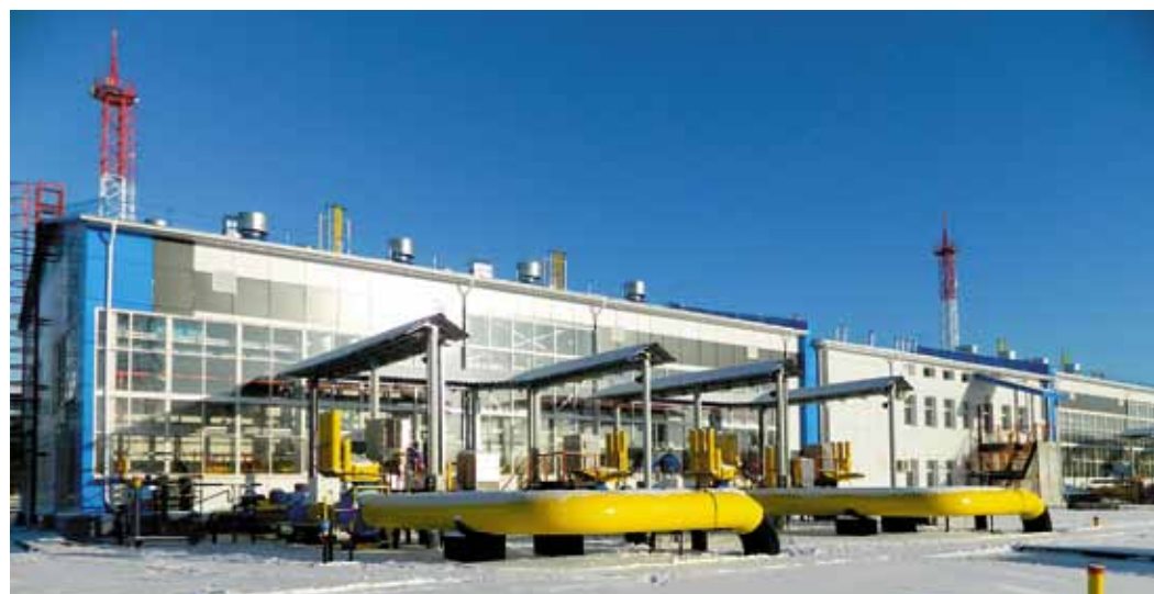
На новом оборудовании КС «Чажемто» – пусконаладочные работы
