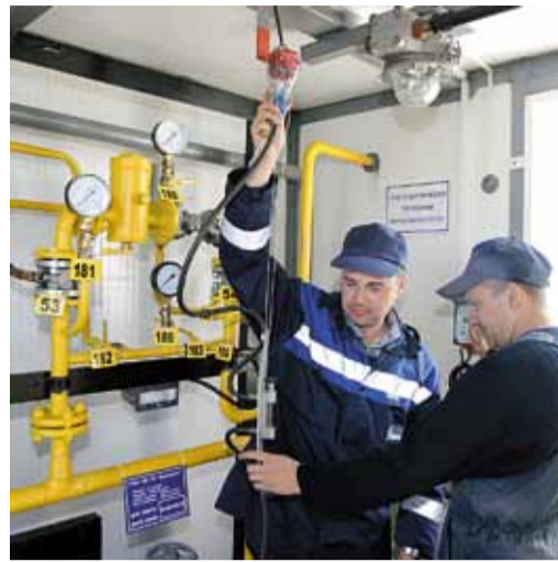
Проверка загазованности помещений на объектах линейной части – одна из важных составляющих охраны труда
