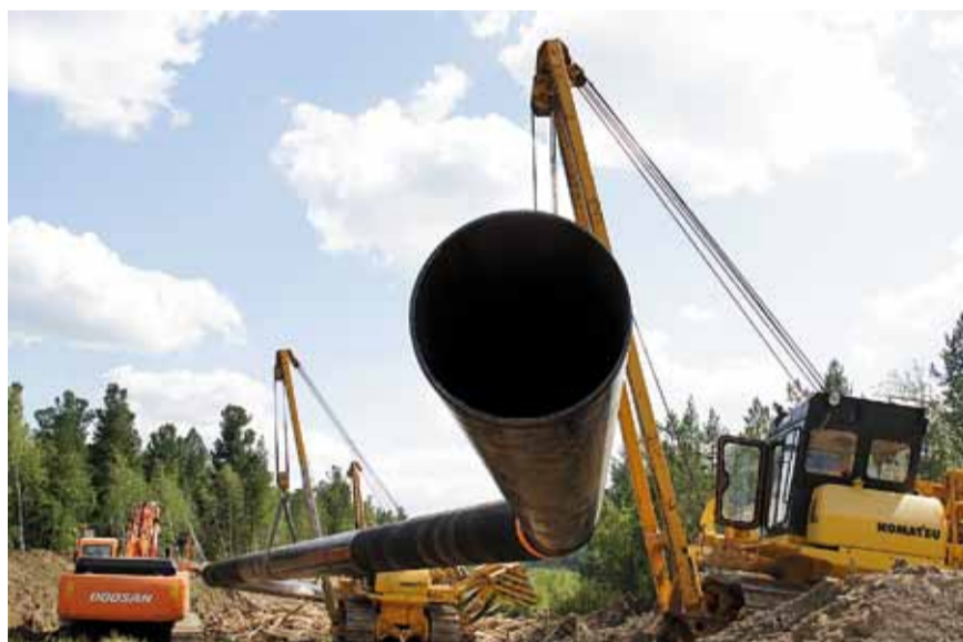
Проведение планового ремонта на газопроводе – основа основ безопасного транспорта газа
